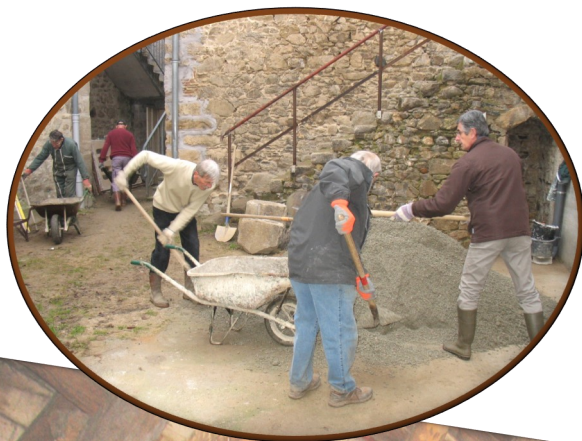
Vue de l'Intérieur à rénover
