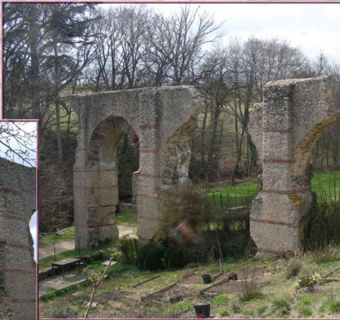
Arches porteuses du canal à Mornant
